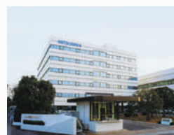
Usine de Shizuoka au Japon
