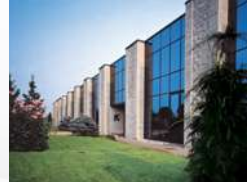
Usine de Pavie : IT Cooling
