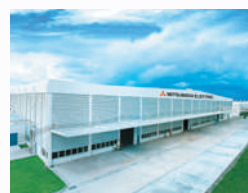
Usine de Chonburi en Thaïlande
